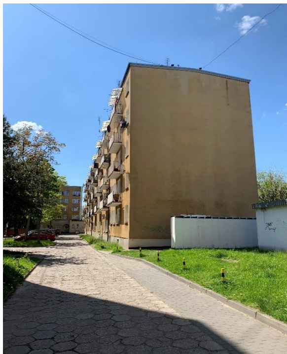
Widok elewacji południowej i wschodniej
