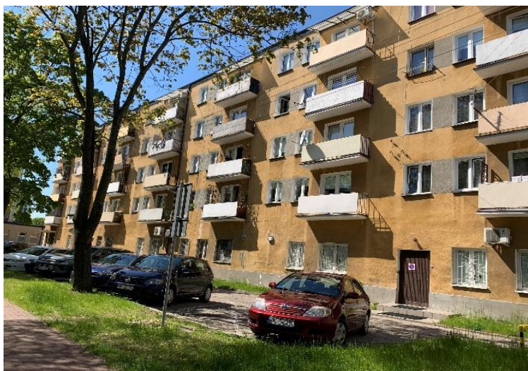
Widok elewacji południowej
