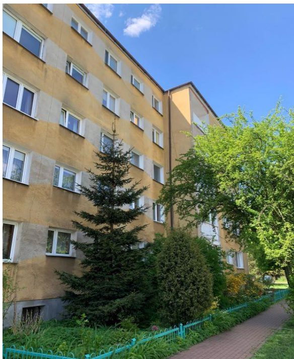
Widok elewacji wschodniej
