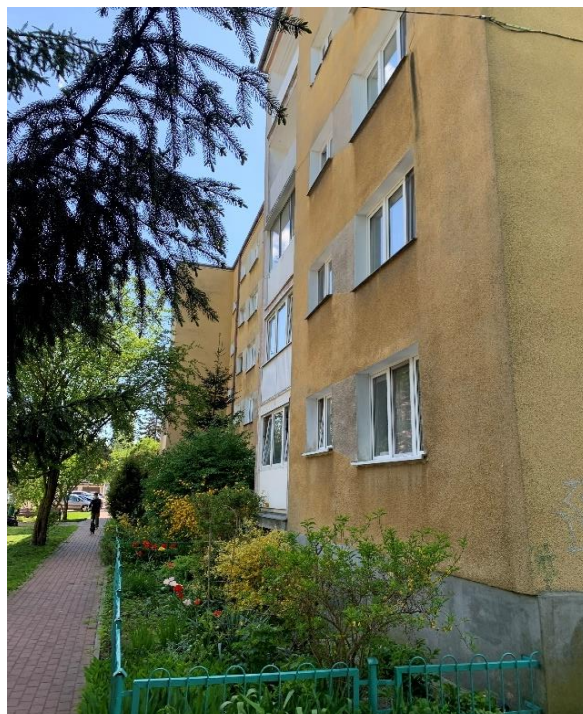
Widok elewacji wschodniej
